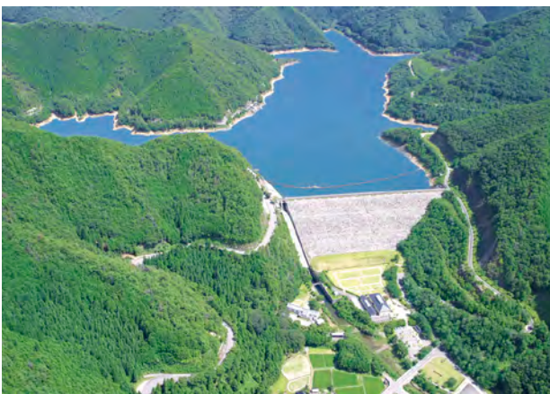
Okutataragi Hydro Power Plant (Kansai EPCo)
